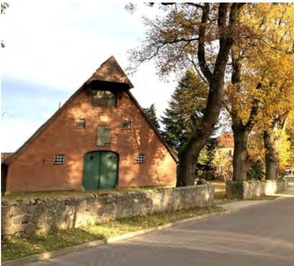
Abb. 13 Wohnwirtschaftsgebäude mit Kranch im Giebel
