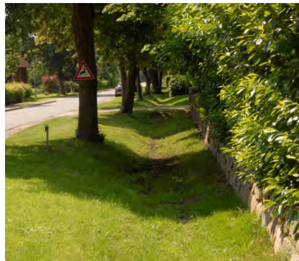
Abb. 45 Beispiel innerörtliche Versickerungsmulde im Straßenraum
