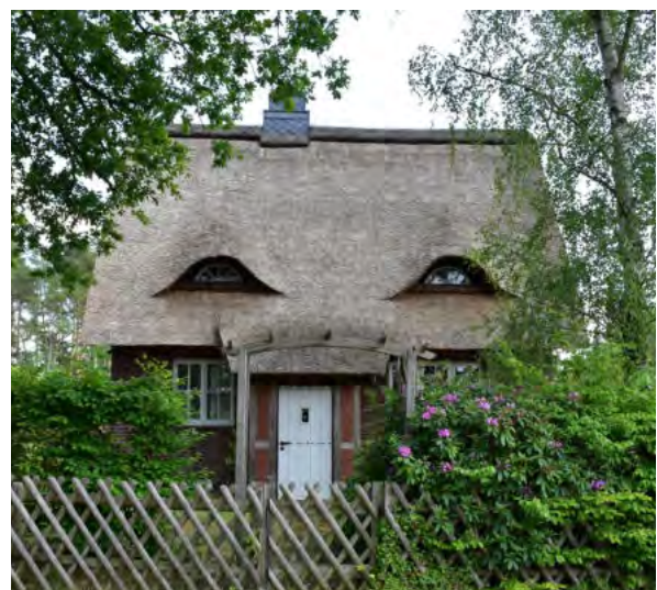
Abb. 8 Reetdach der Region
