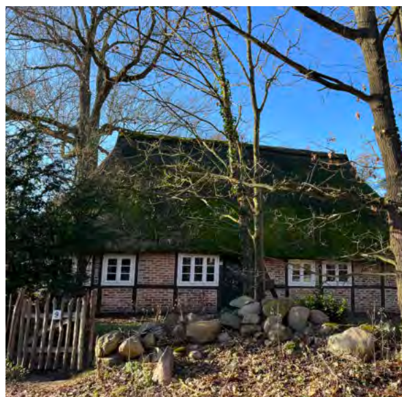
Abb. 3 Einfriedung Staketenzaun mit Steinwall
