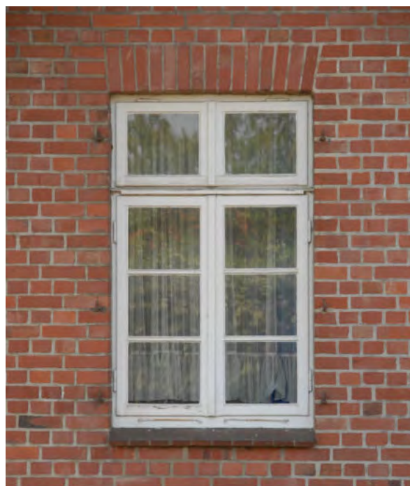
Abb. 34 Beispiel Fenster mit einfacher Sohlbank
