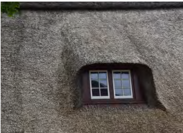
Abb. 20 Beispiel Fledermausgaube im Reetdach
