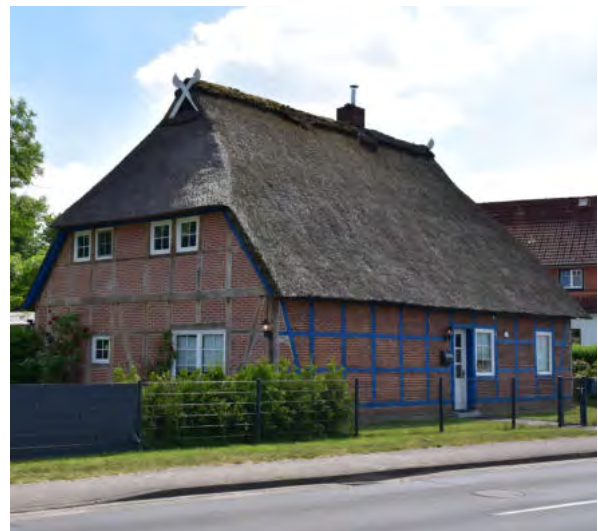
Abb. 7 Reetdach der Region
