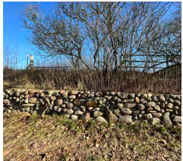
Abb. 43 Beispiel Einfriedung aus Naturstein, trocken aufgesetzt
