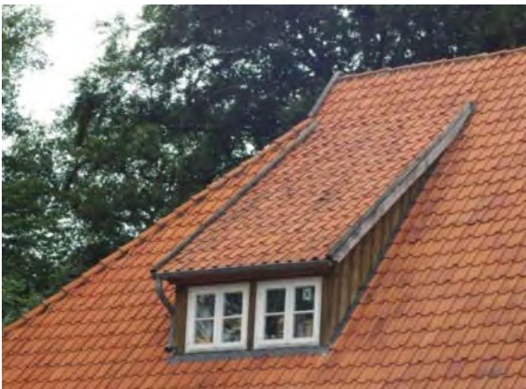
Abb. 19 Beispiel Schleppdachgaube mit seitlicher Holzverschalung
