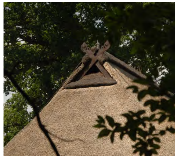
Abb. 24 Beispiel eines Eulenlochs
