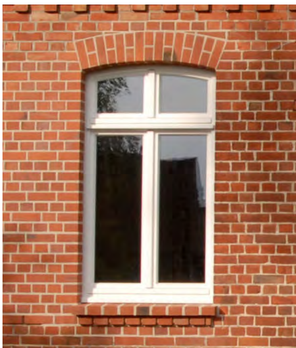
Abb. 33 Beispiel Zweiflügeliges weißes Fenster mit Oberlicht (um 1900)
