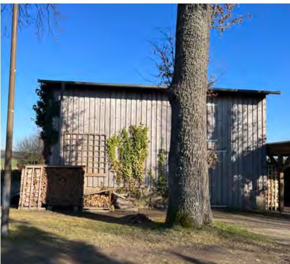
Abb. 27 Beispiel für Holzverschalung am Nebengebäude
