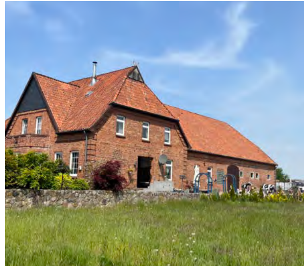
Abb. 9 Ziegeldächer der Region
