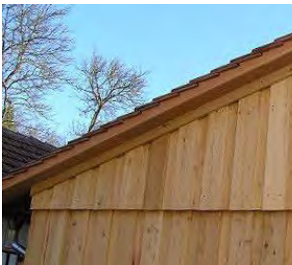
Abb. 22 Beispiel Dachabschluss mit Zahnleiste
